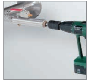
CS delme tertibatı ile basınç altında delme
